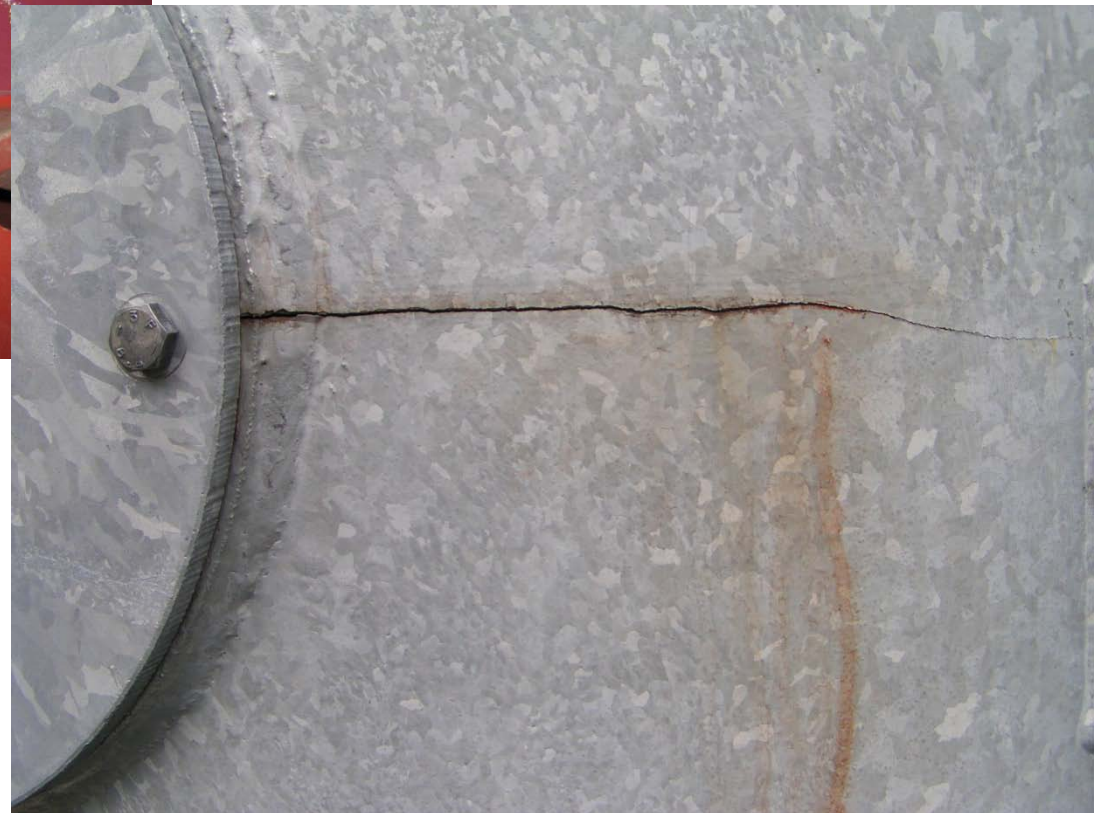
Riss bei Stahlkonstruktion
