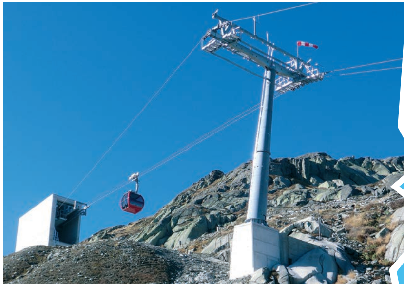
Statt drei nur eine 16 m hohe Stütze mit Spurerweiterung
