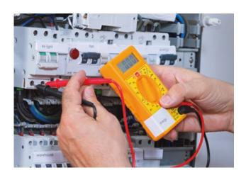
Elektrische Anlagen (Hoch- und Niederspannungsanlagen) sind gemäß ÖVE/ÖNORM EN 50110-1 "Betrieb von elektrischen Anlagen" und alle 5 Jahre zu überprüfen.
