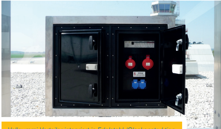
Vollgummi-Verteiler integriert in Edelstahl-/Glaskonstruktion versperbar - kein Zugriff für Unbefugte
