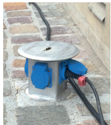
Bodensteckdosen versenkbar, Stromentnahme bei Bedarf, je nach Modell mit belegbarem Deckel - somit optimal ins Umfeld integrierbar
