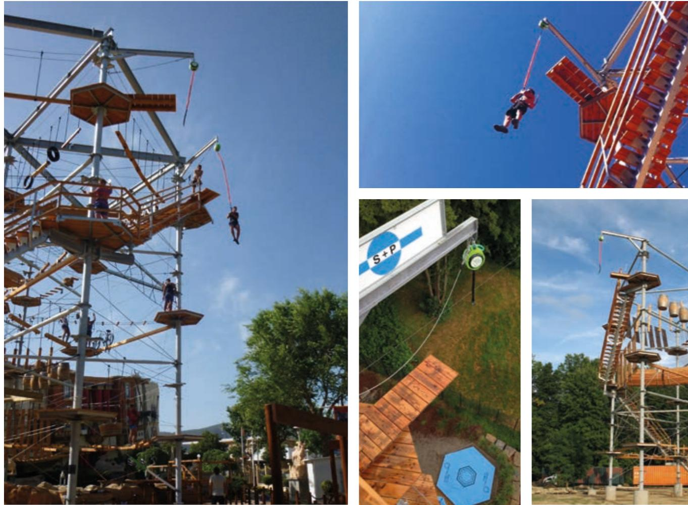
Bei diesem Anbauteil stürzt sich der Besucher in die Tiefe und erlebt ein echtes Freifallgefühl. Das Bremssystem des Abseilgerätes verlangsamt den Fall rechtzeitig. Der Gast wird kontrolliert auf den sicheren Boden hinabgelassen. Ein echter Nervenkitzel und besondere Attraktion für alle Besucher, groß oder klein. Das System ist sehr wartungsarm. Es ist für Kinder und Erwachsene geeignet und lässt einen hohen Durchsatz zu.
