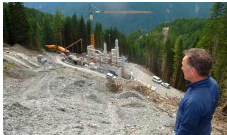
Die PS300 besteht durch 2 Hochdruckpumpen zu jeweils 75 kW und einer Gesamtförderleistung von 50 l/s. In Summe werden zudem noch über 8.000 Meter Druckrohre verlegt.
